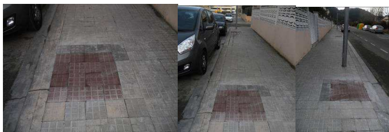
Obres realitzades al gener de 2012 per tancar uns 40 espais destinats a la plantació d'arbres als carrers del barri de Nialó
